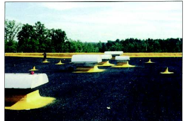
Auto remate de cubiertas de parapeto (flashing)
