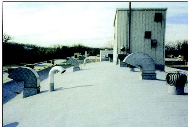
Sistema monolítico de espuma de poliuretano para techos terminado
